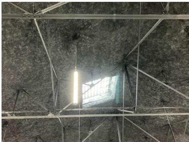
Le puits de lumière au plafond
